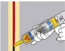
Mantén firme la pistola en la junta y desliza presionando para rellenar completamente la junta o grieta.
