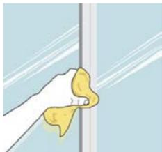
**Limpia** la superficie o borde de la unión o junta dejándola secar y que esté sin restos de polvo o material desprendido.
