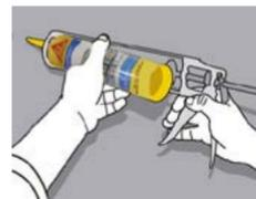
Coloca el fondo de junta **SikaRod®** del ancho adecuado a todo lo largo. Corta la boquilla del cartucho dependiendo del ancho requerido. Perfora la membrana de protección, colócala en la pistola de calafateo y aplícala. Para salchichas usa la pistola universal Sika.
