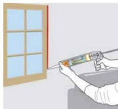
**Aplica** un cordón del producto mínimo 6 mm de lado en la junta o unión. Resane mínimo 2-3 mm.
