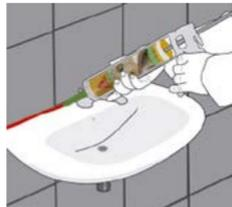
**Rellena la junta** con SikaSeal®-114 B&C evitando atrapar aire y la formación de burbujas. Aplica un cordón de 6 mm de lado de la unión.
