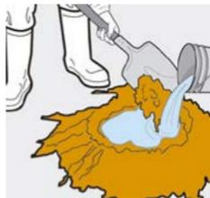
Agrega el agua de amasado y mezcla bien el mortero o concreto. Aplícalo y cúralo con agua o **Sika**<sup>®</sup> **Curador**.
